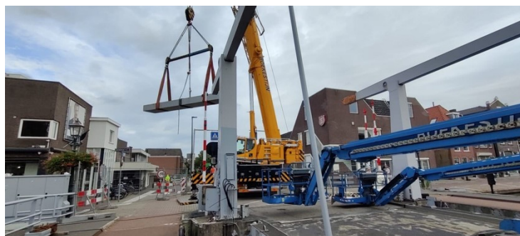
Demontage brugonderdelen
